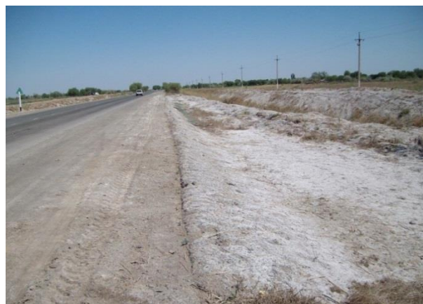
Рис. 2. Участок автомобильной дороги Халкабад-Кегейли, 3 км
