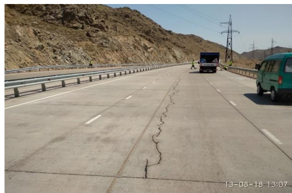
Рис. 2. Результаты негативного воздействия движения грузовых АТС с перегрузом на автомобильных дорогах Республики Узбекистан
