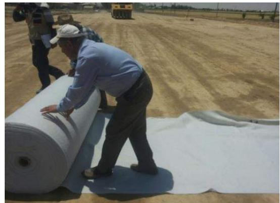
Рис. 6. Укладка геосинтетического материала и выравнивание грунтов
