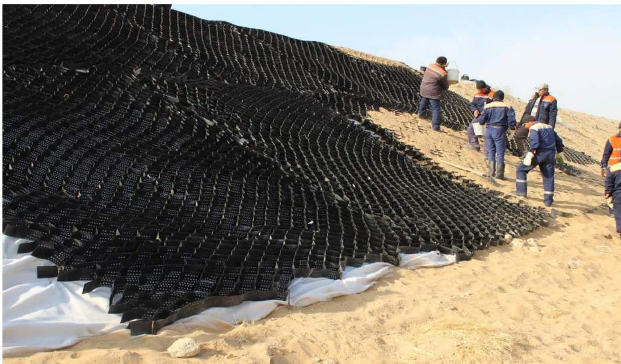
Рис. 3. Процесс укладки георешеток и заполнения местным грунтом ячеек с параллельным посевом семян пескостойких трав (перегон Кийикли – Хизирбобо км 4199 ПК 1)
