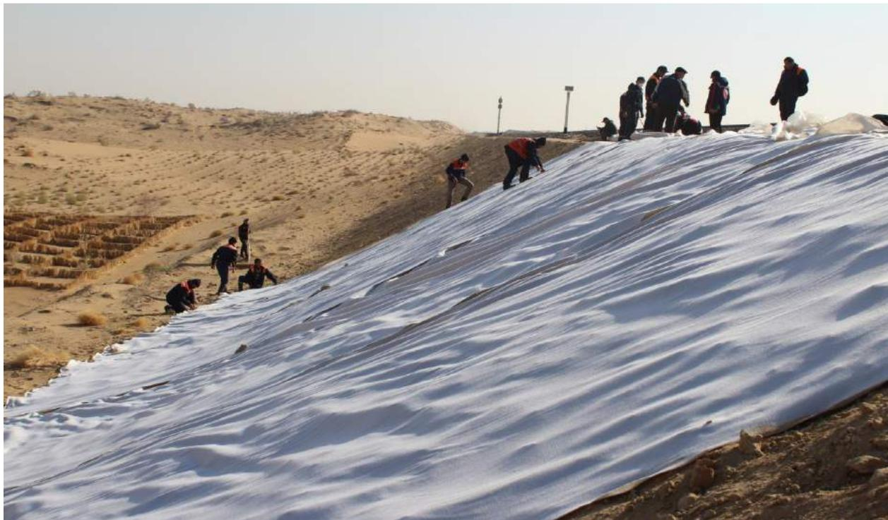
Рис. 2. Процесс укладки геотекстиля на откос земляного полотна (перегон Кийикли – Хизирбобо км 4199 ПК 1)
